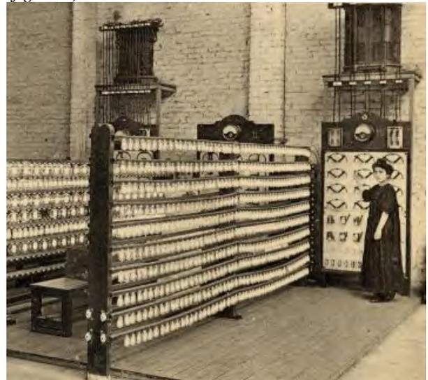
**Figure 8 :** rampes d'essai
