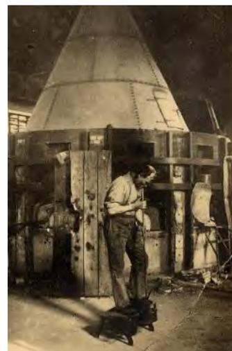
Figure 4 : soufflage d'une ampoule
