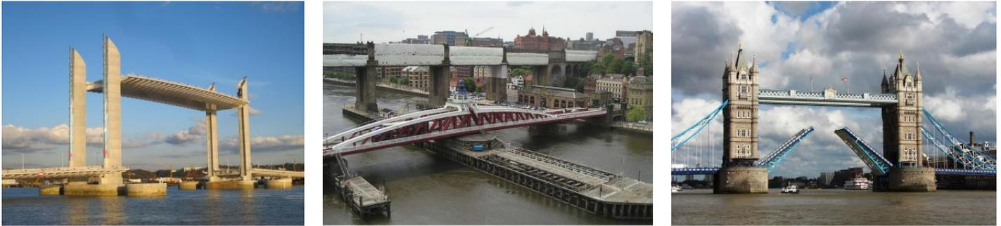
Figure 1 : Exemples de solutions : pont levant Jacques-Chaban-Delmas (Bordeaux), pont tournant entre Newcastle upon Tyne et Gateshead (Angleterre), pont basculant Tower Bridge (Londres), sources [5], [6] et [7]
