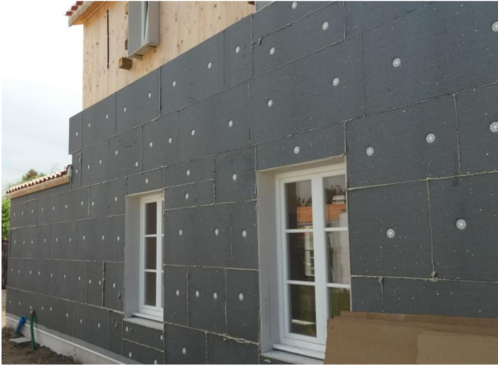
Figure 47 : Panneaux d'isolant vissés et collés sur le panneau et collés entre eux, source C. Launeau
