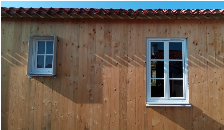
Figure 44 : Pose des menuiseries avec précadre et cadre en fibrociment, source C. Launeau
