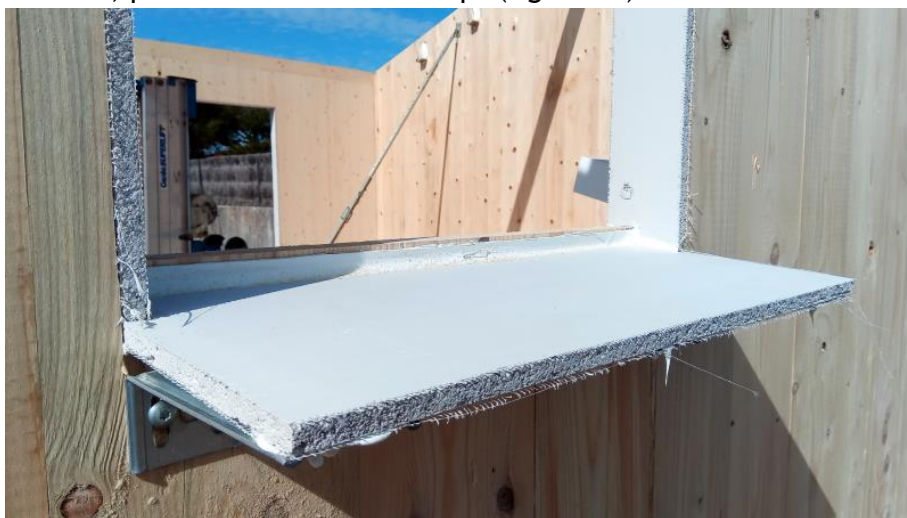
Figure 42 : Pose d'un cadre en fibrociment dans les ouvertures, source C. Launeau
