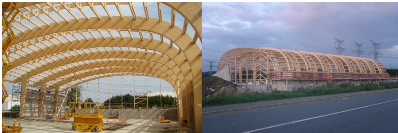
Figure 22 : Charpente en lamellé-collé du gymnase à Roissy-en-Brie, source [25]
