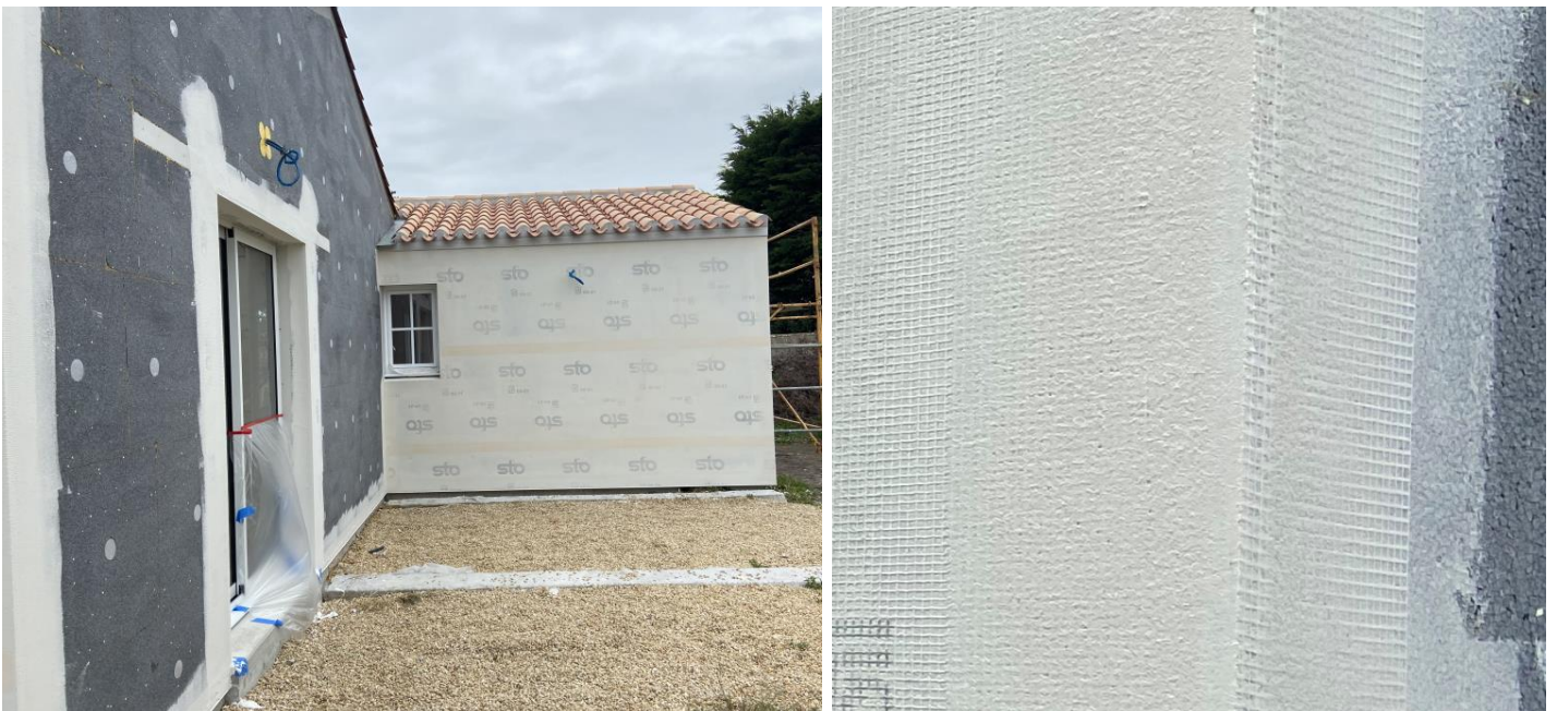
Figure 48 : Finition extérieure, à gauche seuls les angles sont renforcés, mur de droite les deux premières couches et la trame polyester sont posées et détail de ces couches et trame, source C. Launeau
