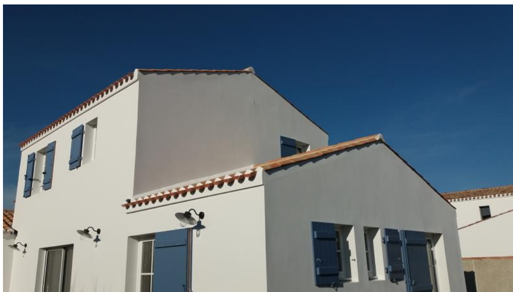
Figure 49 : Bâtiment avec enduit fini, l'apparence est identique à une maison maçonnée visible à l'arrière à droite, source C. Launeau
