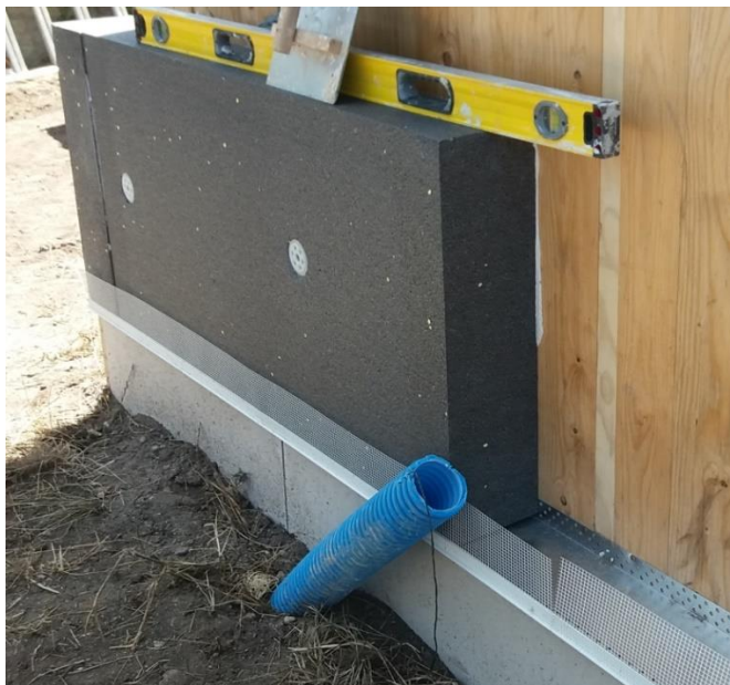
Figure 46 : Pose de l'isolant avec trame polyester source C. Launeau
