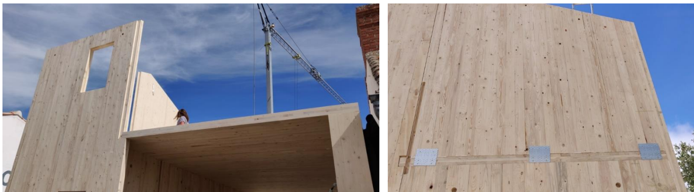
Figure 41 : Pose des murs de l'étage et fixations extérieures, source C. Launeau
