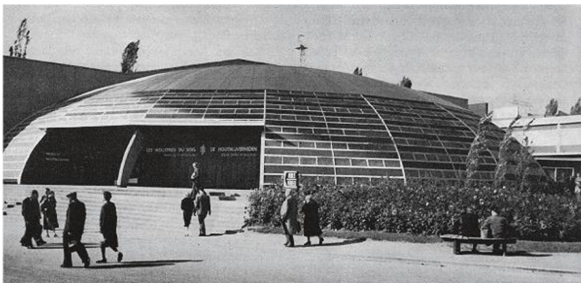
Figure 21 : Photo d'un des pavillons de l'Exposition universelle de Bruxelles en 1958 avec sa demi-coupole de 1390 m 2 en lamellé-collé, © Guide Officiel Exposition Universelle de Bruxelles 1958, source [24]
