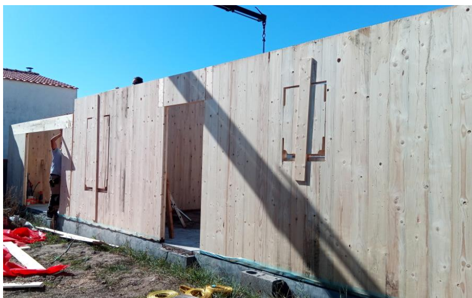
Figure 37 : Pose des panneaux avec les ouvertures prédécoupées, source C. Launeau
