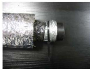
On insère le piquage dans le conduit intérieur et on positionne la bande ( pour l'étanchéité), on fixe le conduit intérieur sur le piquage à l'aide d'un serflex (pour la tenue mécanique).
