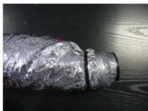
On scotch avec de la bande Alu la gaine contre le piquage (propreté), Serrer le tout à l'aide d'un second serflex (pour la tenue mécanique).
