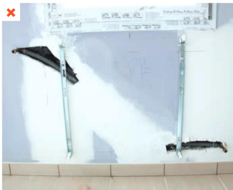
Adaptation de la longueur des tuyaux aux dimensions du nouveau radiateur permettant l'ouverture de la fenêtre. ©AQC-2015
