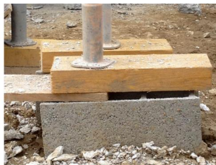
Appui sur un corps creux Empilage excessif de cales Appui sur un vide Terrain non nivelé
