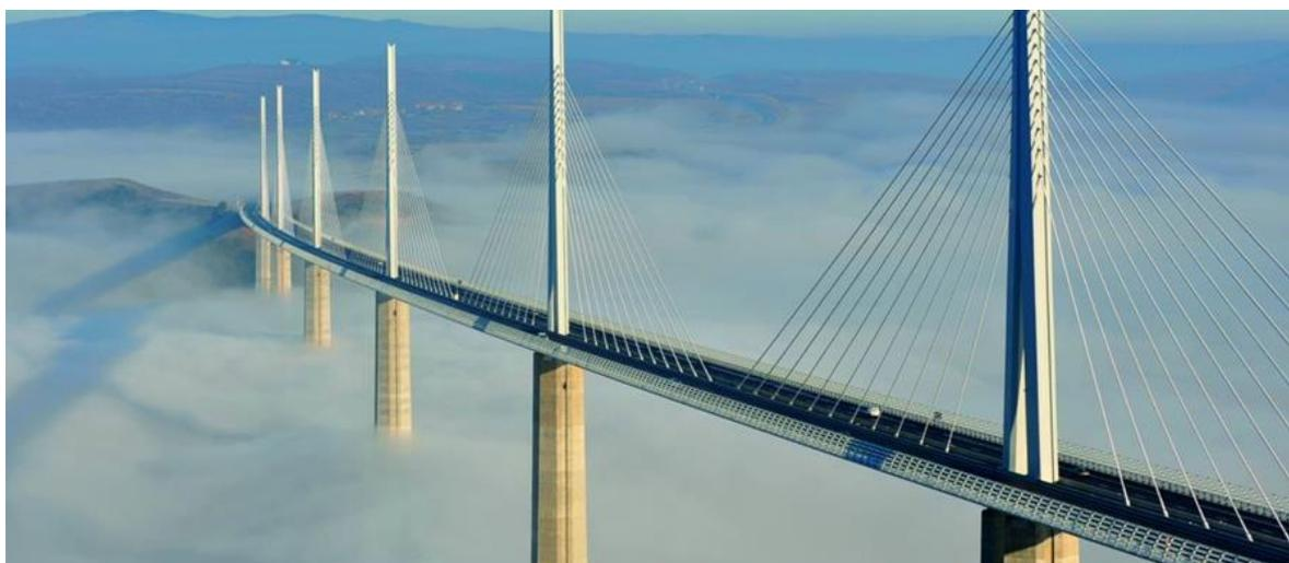
Figure 4 : Le viaduc de Millau, exemple d'un pont à haubans, source [3]
