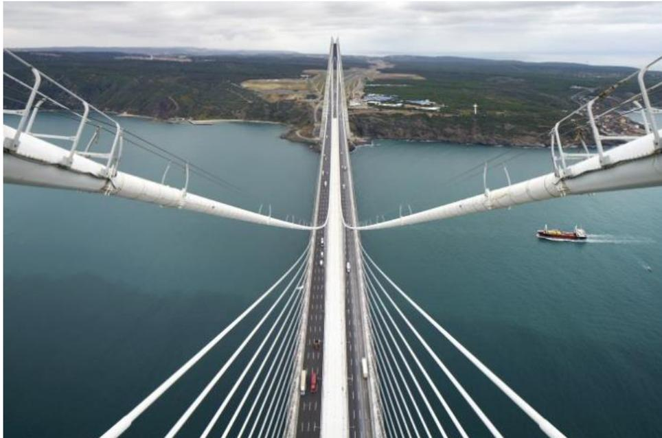
Figure 27 : Position du câble porteur et donc des suspentes verticales, source [24]
