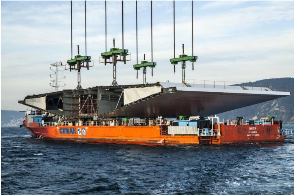
Figure 25 : Mise en place d'un voussoir, source [29]
