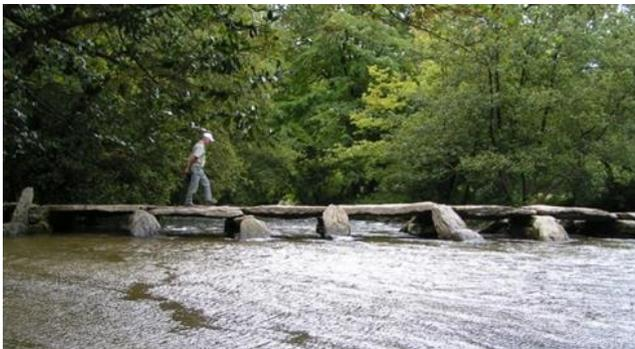
Figure 8 : Le Tarr Steps, Grande-Bretagne, pont de dalles de pierres du 1<sup>er</sup> millénaire av. J.-C., source [6]
