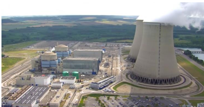
Figure 7 : Centrale nucléaire de Nogent-sur-Seine, source [19]
