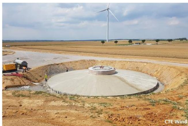
Figure 9 : Fondations d'éolienne, source [8]
