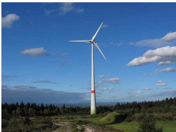
Figure 8 : Éolienne avec un mât en béton, source Enercon
