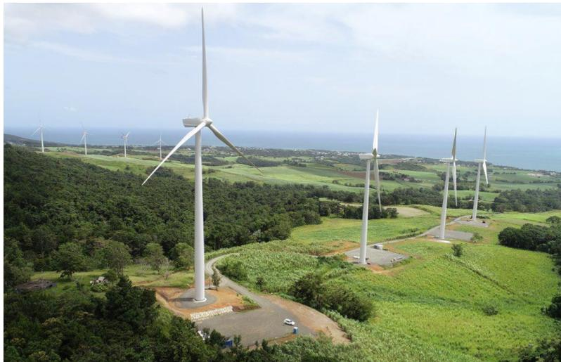
Figure 10 : Voies d'accès et aires de levage, source [16]
