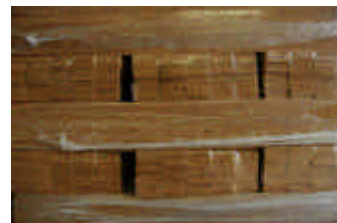
Joints de dilatation en liège aggloméré
