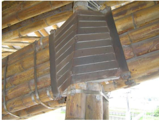
Figure 24 : Assemblage de poutres, catégorie 6, source [25]
