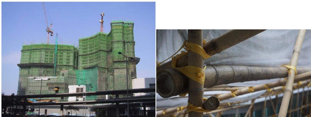
Figure 15 : Construction d'échafaudage en bambou, sources [14] et [15]
