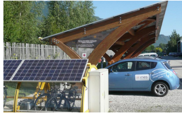
Figure 65 : Parkings avec ombrières photovoltaïques associées à des bornes de recharge à l'Institut National de l'Energie Solaire, Le Bourget du Lac, photos B. Multon
