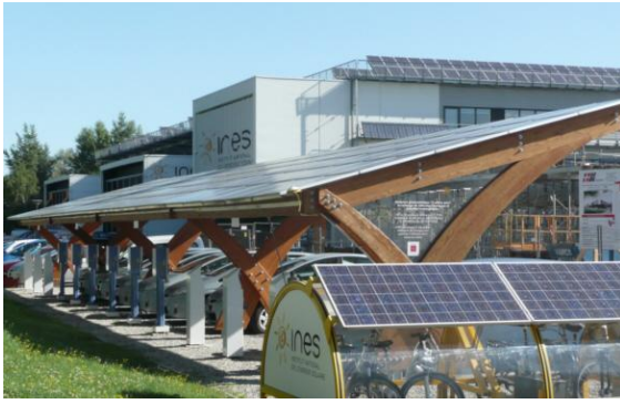
Figure 65 : Parkings avec ombrières photovoltaïques associées à des bornes de recharge à l'Institut National de l'Energie Solaire, Le Bourget du Lac, photos B. Multon
