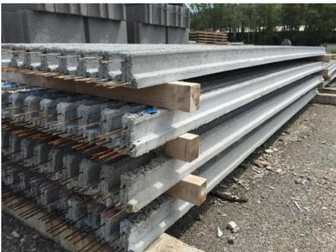
Figure 11 : Poutres en béton précontraint, source Perasso Alpes
