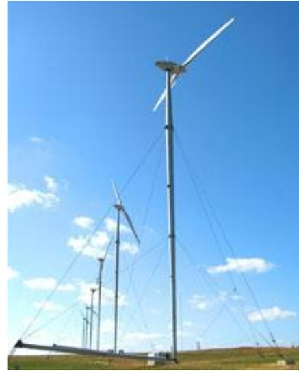
Figure 6 : Mats haubanés d'éolienne, source Galva Union
