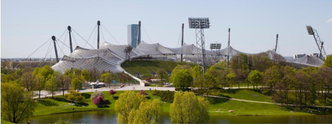
Figure 10 : Stade de Munich (Allemagne), toiture soutenue par des câbles en réseaux, source [10]
