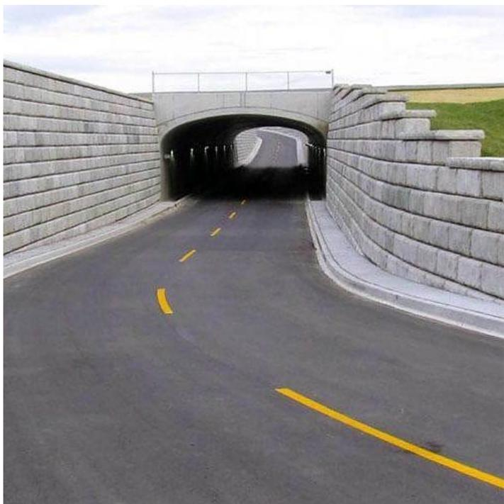
*Mur de soutènement par blocs béton [pbrock.fr]*
