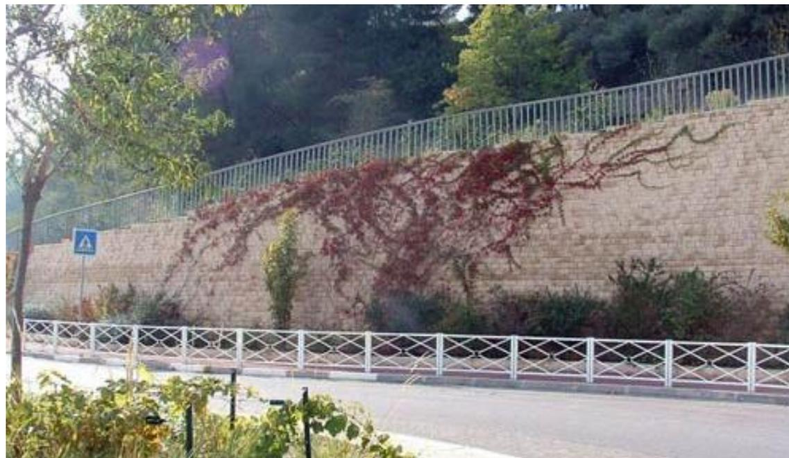
*Soutènement par blocs béton, Rond-point RD 58, commune de Gardanne, [betoconcept]*
