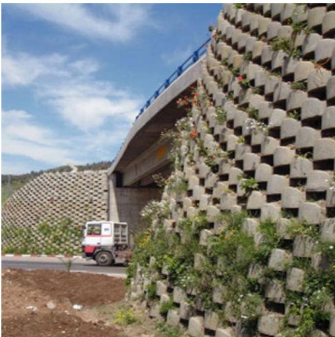
*Mur de soutènement par blocs béton [batiproduits.com]*
