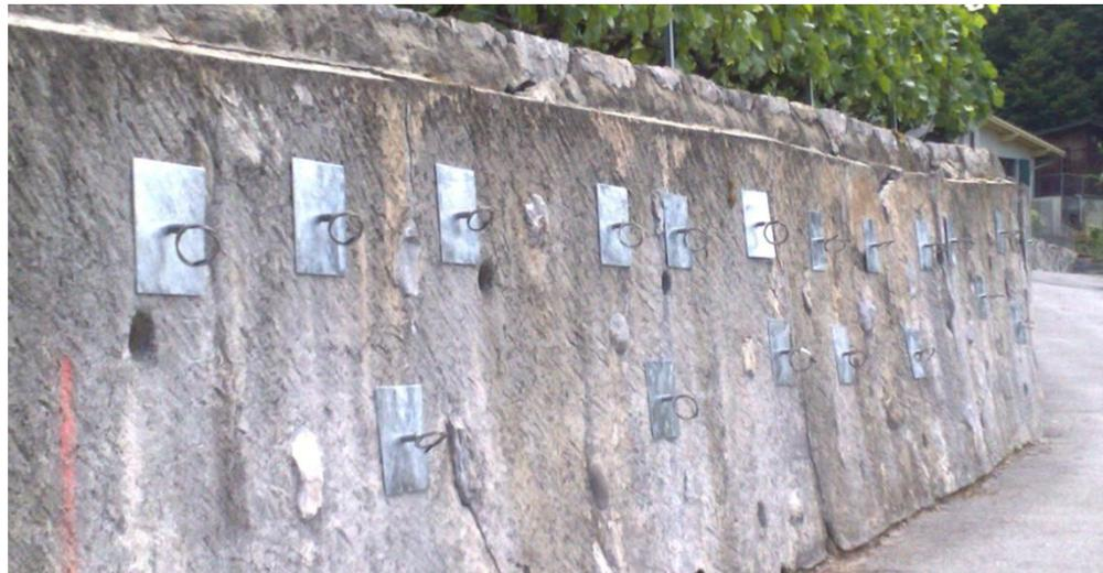
Mur de soutènement de vignes avec tirants d'ancrage [anteq.ch]
