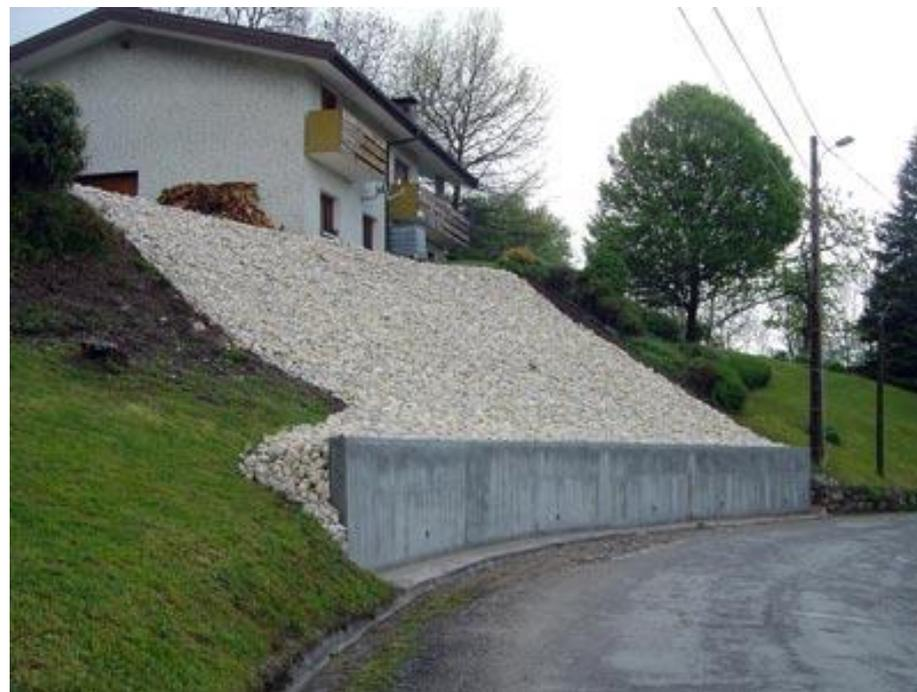
*Mur de soutènement en béton armé, commune de Bonneville [construction-maisons-briques-monomur-garin.com]*
