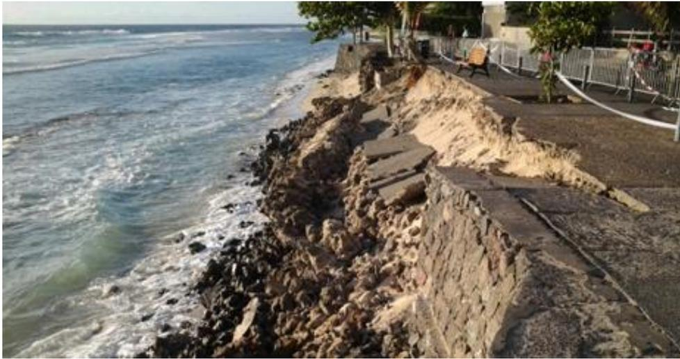
*Effondrement du mur de soutènement de l'esplanade des Roches Noires à La réunion, [BRGM]*
