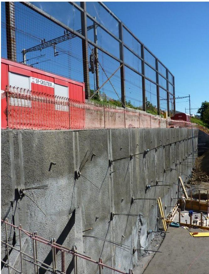
Mur de soutènement avec tirants d'ancrage, [sif-groutbor.ch]
