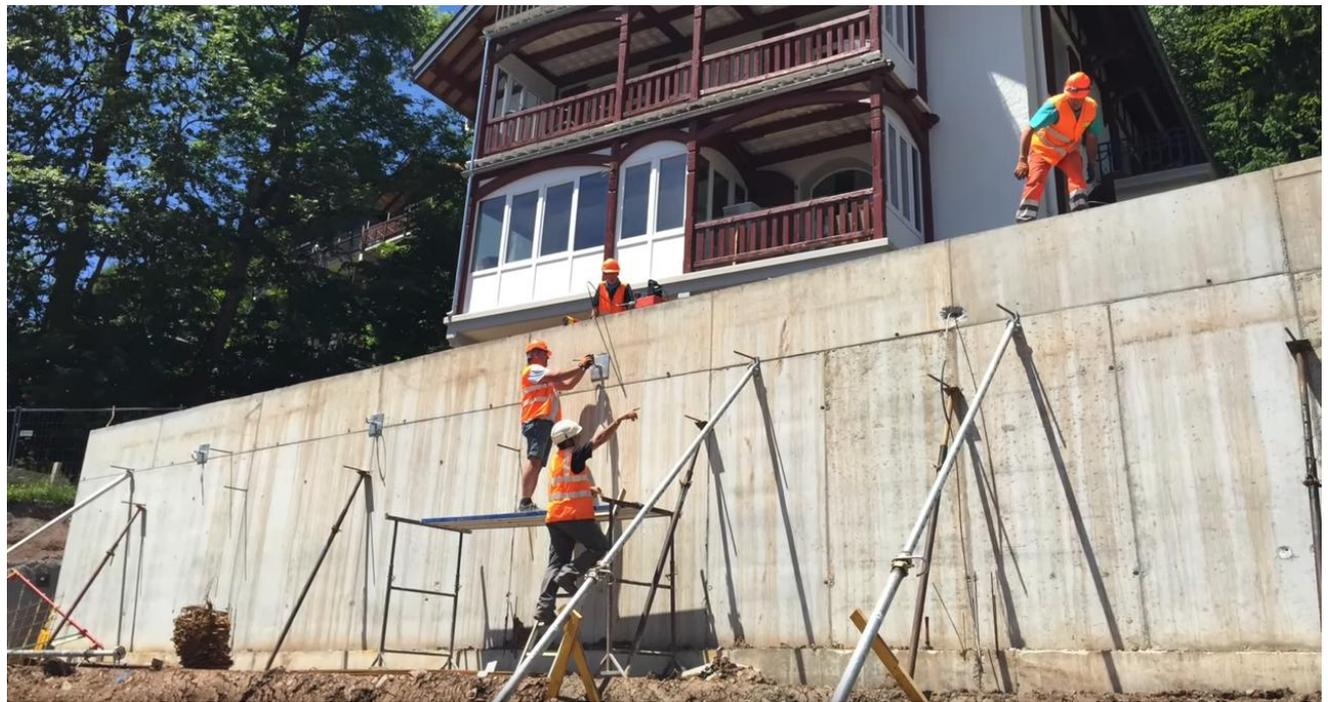
Ancrage par tirants d'un mur de soutènement en béton armé en construction, [ANTEQ SA]
