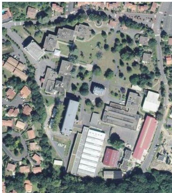
Figure 4-1 - Vue aérienne du lycée Cantau d'Anglet (source : GoogleMap)
