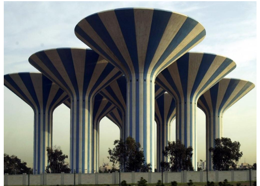
Château d'eau (hauteur 35-40 m, diamètre 40 m), Koweït, [James Patterson, CC BY-SA 2.0]
