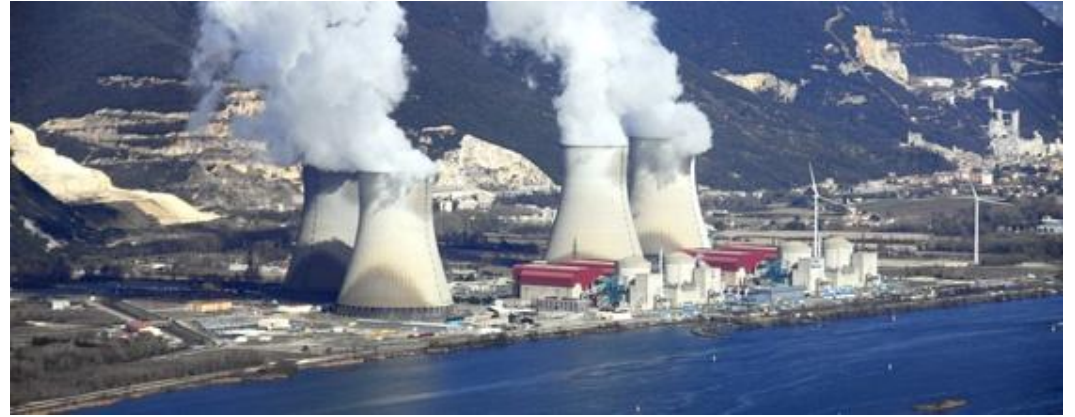
Centrale nucléaire de Cruas, Ardèche, [Marc Cecchetti, actu-environnement.com]
