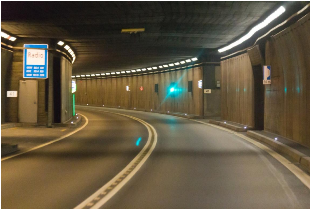
Tunnel routier sous le massif du Saint-Gothard (16,9 km), Suisse, [Raimond Spekking, CC BY-SA 4.0]
