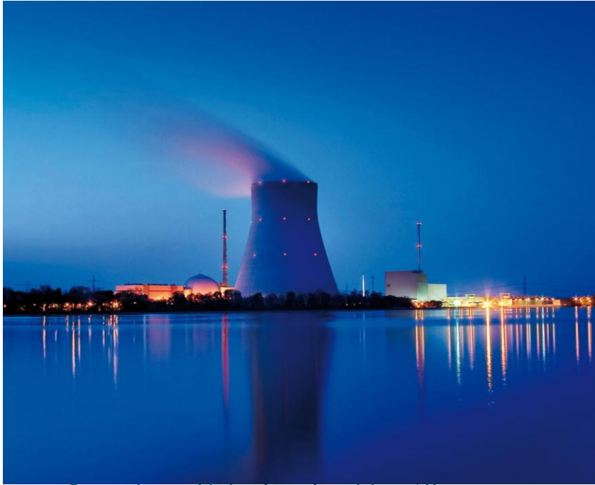
Centrale nucléaire Isar, Landshut Allemagne, [blincker, actu-environnement.com]
