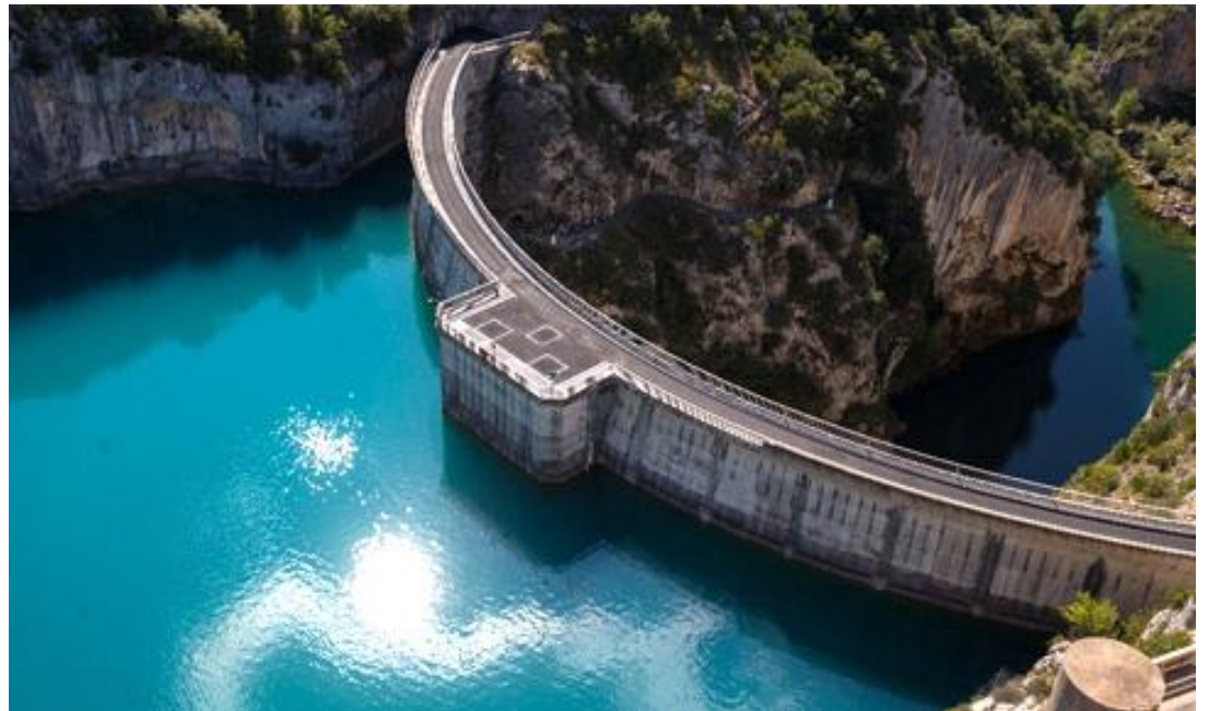
Barrage de Sainte-Croix sur le Verdon, Alpes-de-Haute-Provence (superficie du lac 2180 ha) [alpes-de-haute-provence.gouv.fr]
