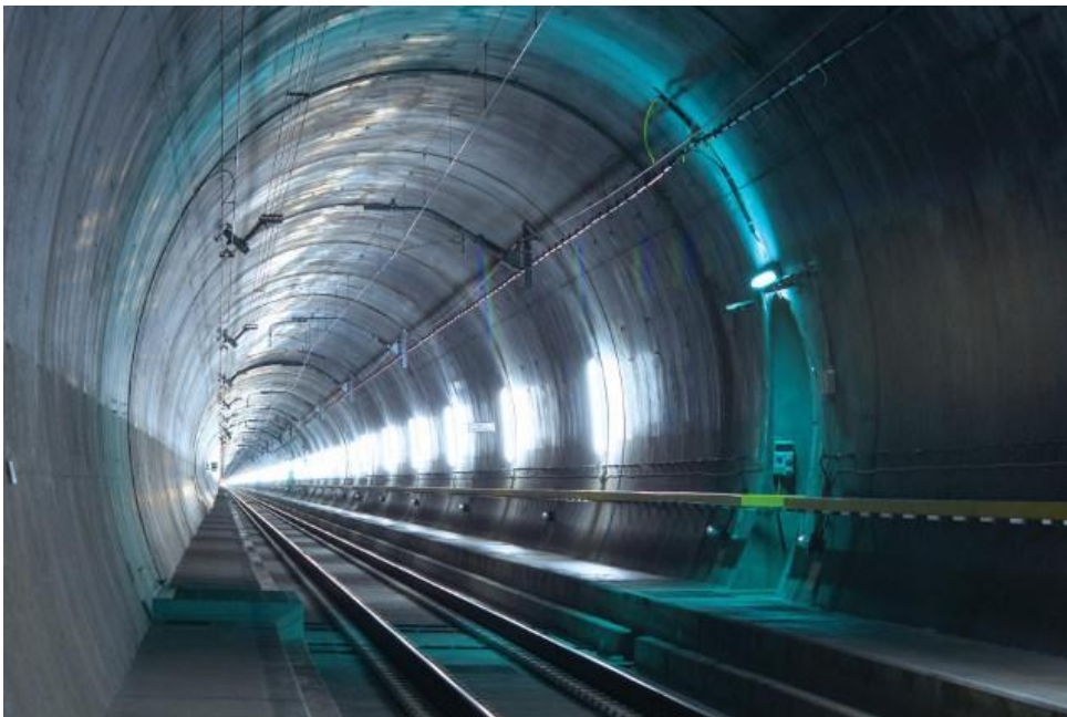
Tunnel ferroviaire bi-tube sous le massif du Saint-Gothard (15 km), Suisse, [Vicat]
