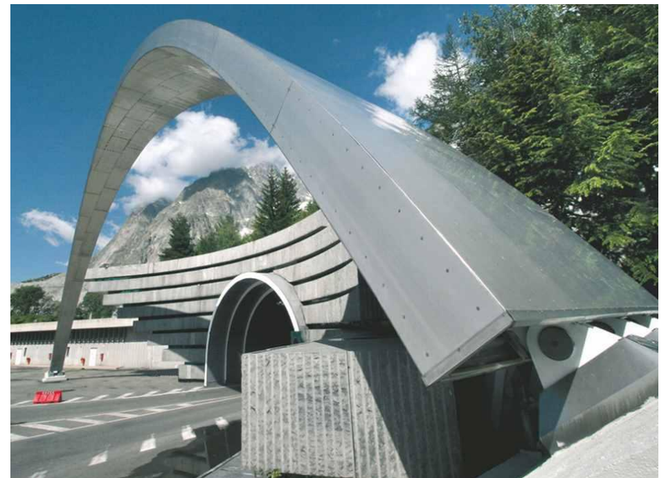
Tunnel routier sous le massif du Mont-Blanc (11,6 km), coté italien
