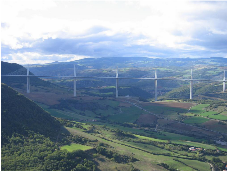
Viaduc de Millau (longueur 2460 m, portée principale 342 m), Aveyron, [Naparish, CC BY-SA 2.0]
