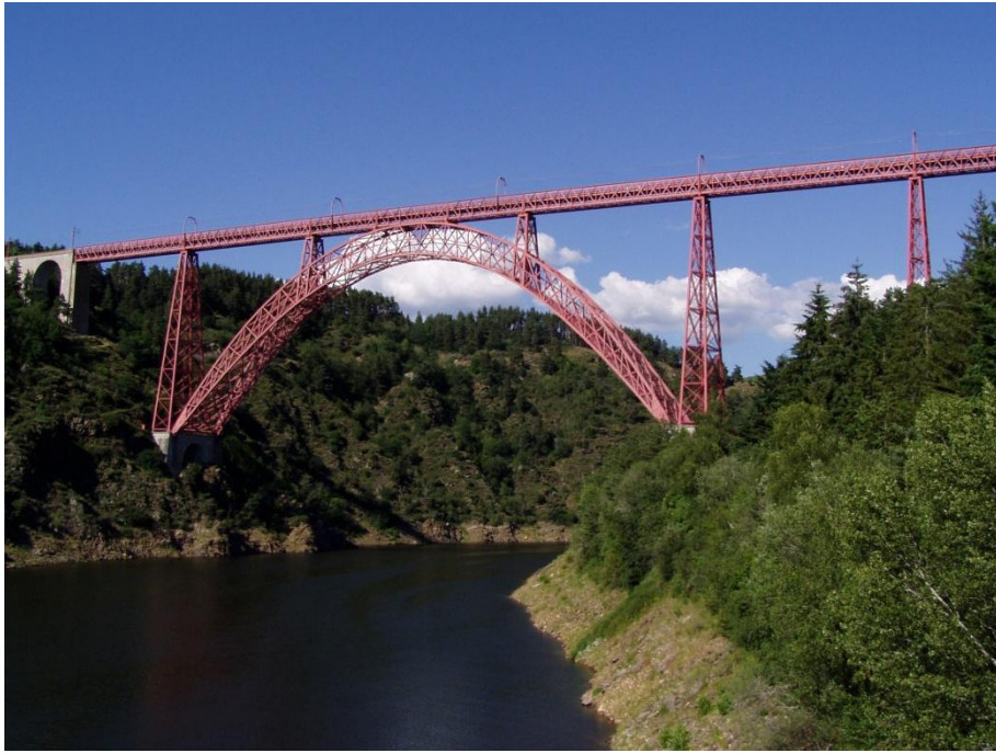
Viaduc ferroviaire de Garabit (portée 165 m), Cantal, [Belgavox, CC BY-SA 3.0]
