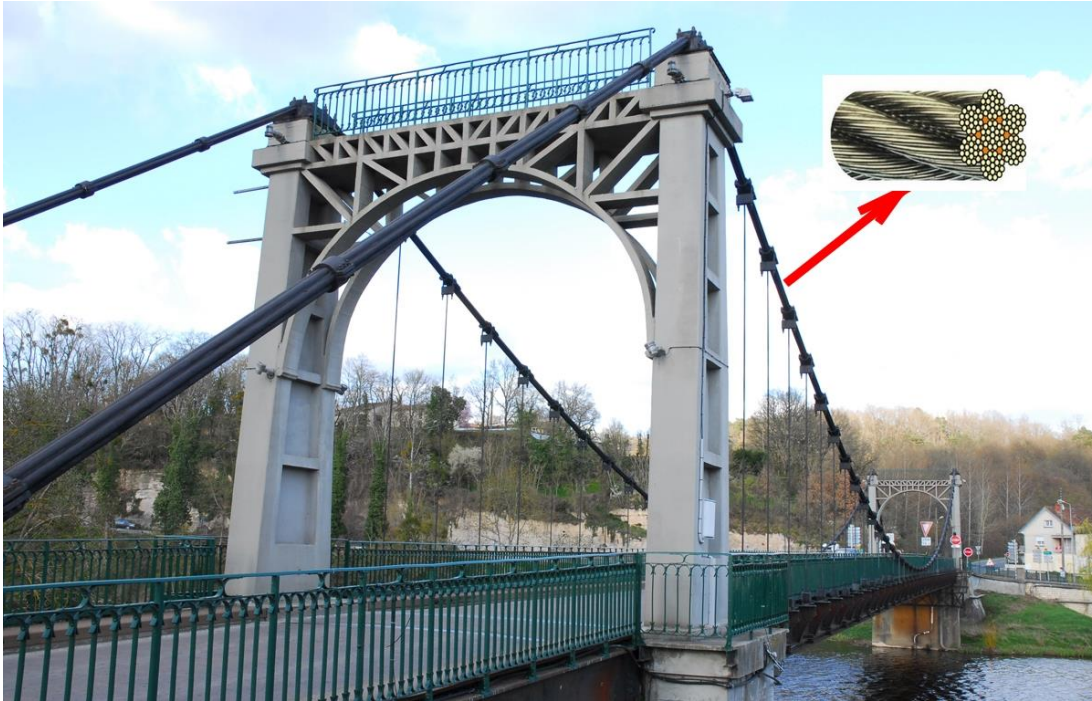
Câble acier à 7 torons, pont suspendu de Bonneuil Matours (Vienne).
