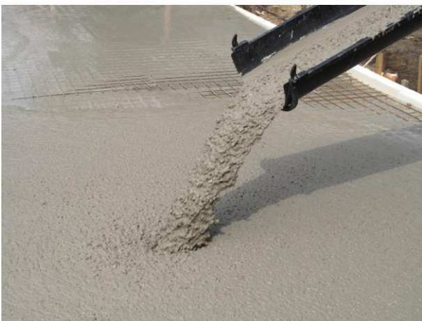
Coulage de béton sur une terrasse
