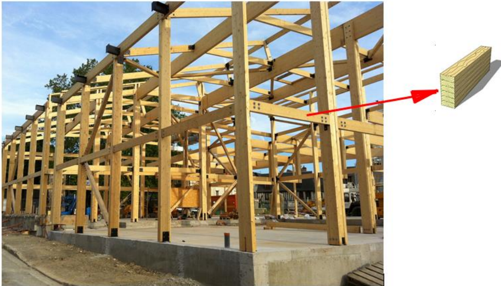
Structure d'un bâtiment en bois lamellé collé
