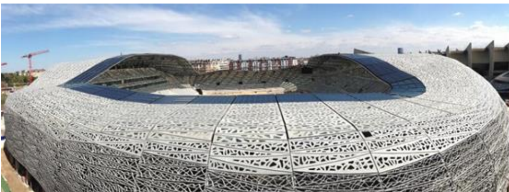
Le stade Jean Bouin (Paris) et son enveloppe en BFUP, architecte Rudy Ricciotti.
