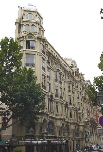
Immeuble Hennebique 1900 (Paris), photo Gérard Métron, site Structurae.
