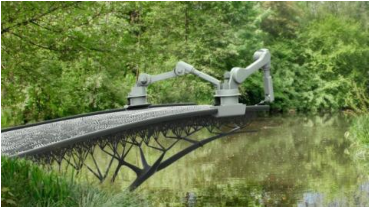
Figure 1 : Pont en acier, imprimé en 3D par des robots, source [1]
