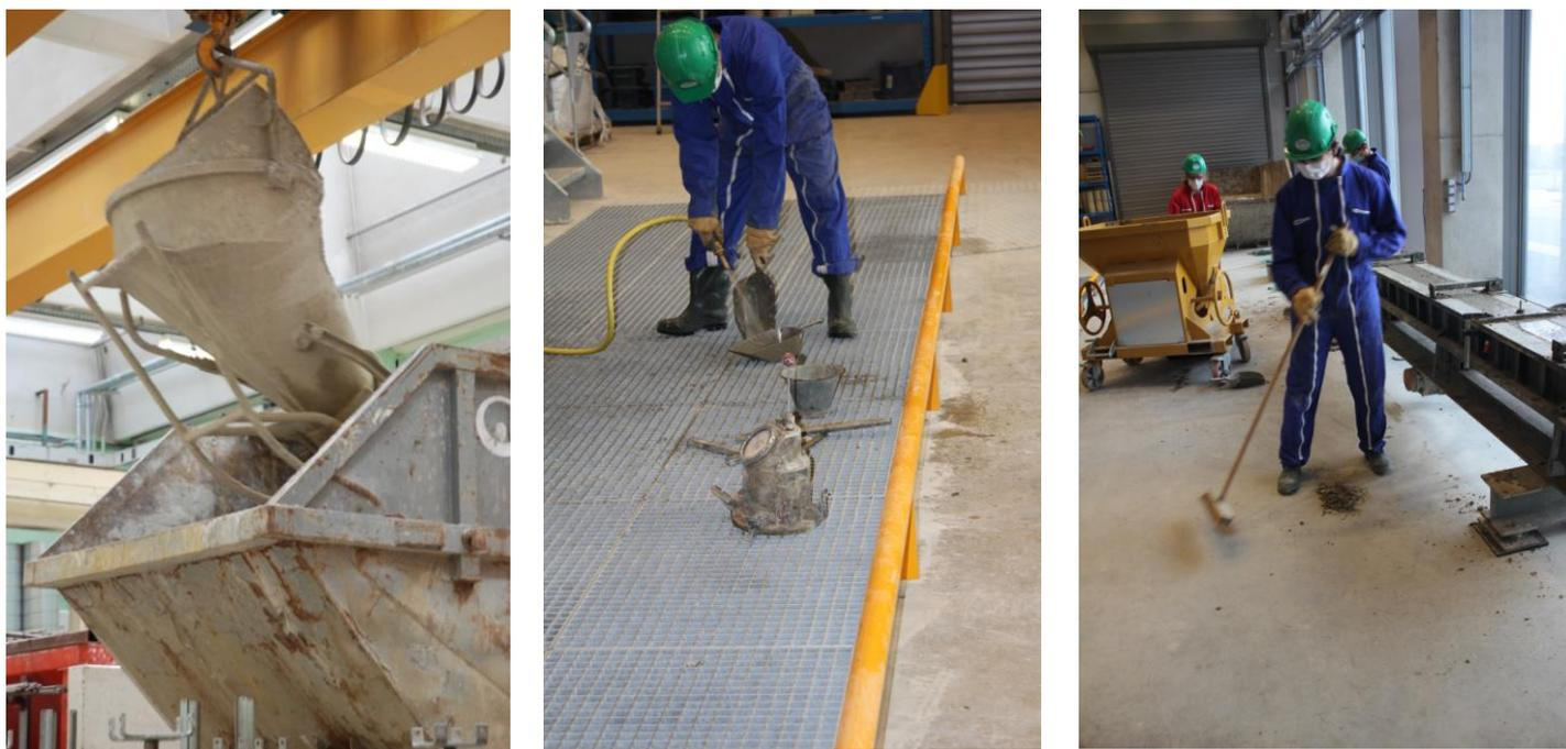
Figure 41 : Évacuation des déchets dans une benne spéciale, nettoyage de l'outillage à l'eau sous pression ou non, et balayage
