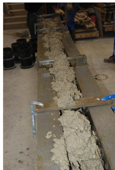
Figure 30 : Dépôt d'une première couche de béton
