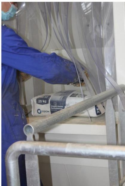
Figure 14 : Ouvverture du sac de ciment (EPI masque et gants)
