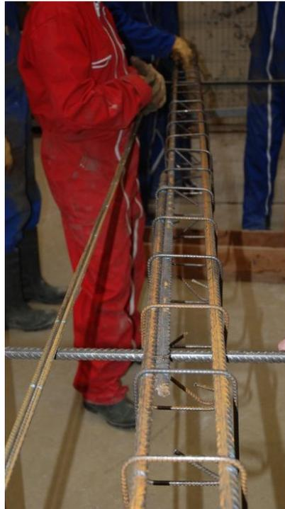
*Figure 10 : Positionnement des cadres*
