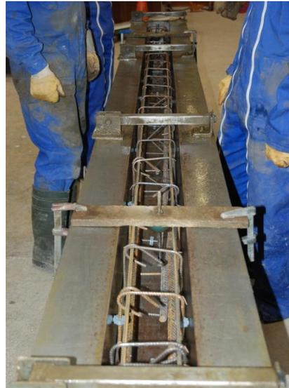
Figure 29 : Finalisation du moule avant remplissage de béton
