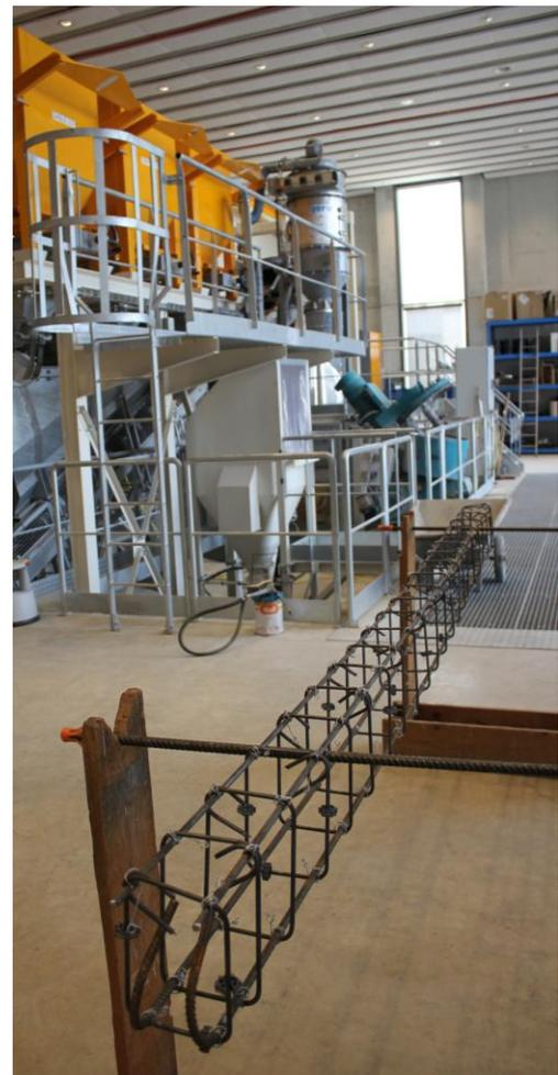
*Figure 12 : Finalisation de la cage d'armature*
