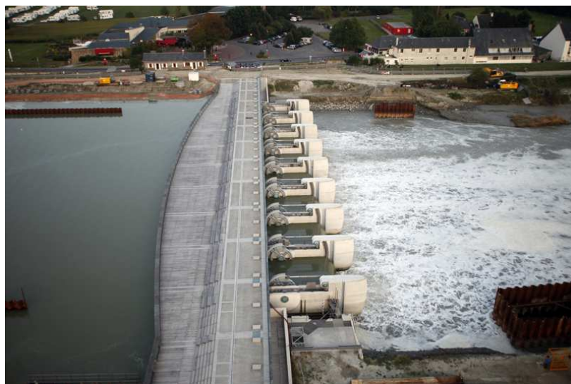
Figure 2 : barrage sur le Couesnon en action
