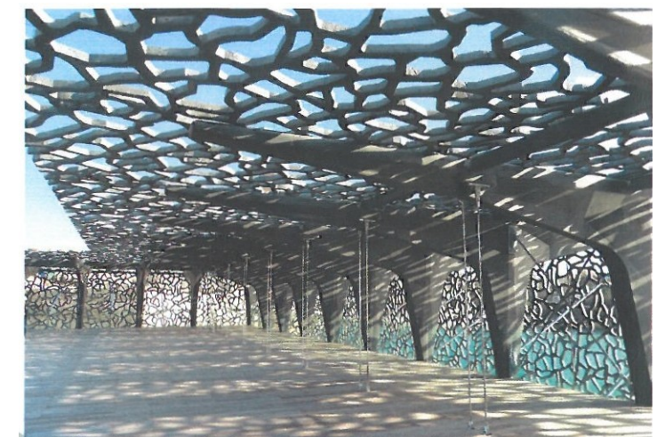
13. MUCEM : Musée des Civilisations de l'Europe et de la Méditerranée réalisé à Marseille en 2013. Rudy Ricciotti, architecte. Matériaux : béton fibré.
