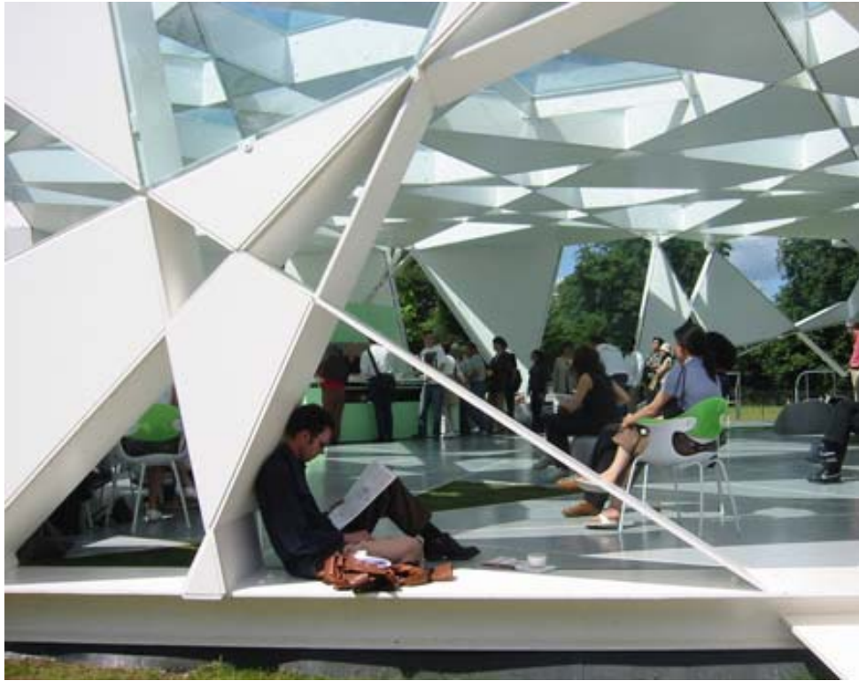
17. Pavillon Serpentine à Londres en 2013. Structure éphémère conçue par Toyo Ito, architecte. . Matériaux : structure métal et verre.
