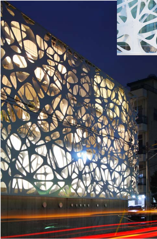
18. Peau extérieure du bâtiment composée d'une membrane épaisse de 20 cm réalisée en plastique et en composite d'aluminium, Tokyo, 2007
