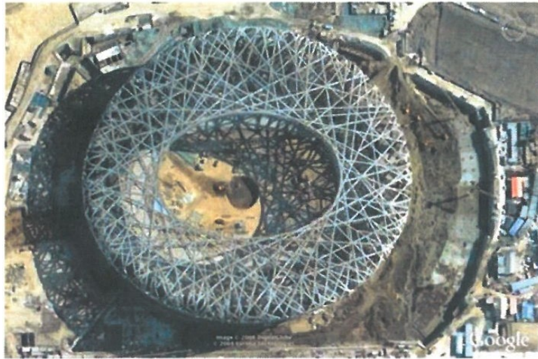
1. Stade national de Pékin (Chine), surnommé le « Nid d'oiseau » pour son architecture, construit pour les jeux olympiques de 2008. Herzog et De Meuron, architectes allemands. Matériaux : bâti en béton recouvert d'une structure en acier.
