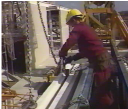
Elingage des panneaux sur le camion
