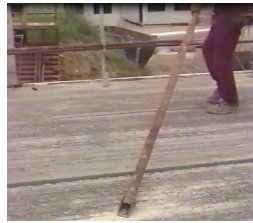
Fixation des tirants-poussants sur le plancher
