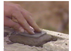
Mise en place des cales (niveau)
