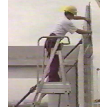
Mise en place des joints verticaux
