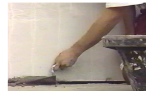
Remplissage du joint
