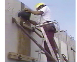
Clavetage des panneaux
