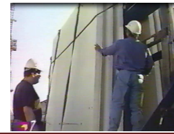
5 Vérification des panneaux avant pose
