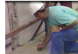
Positionnement du panneau (alignement)
