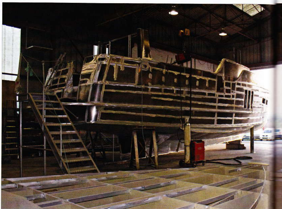
Dans le chantier de Condé-sur-Noireau, la carène est composée de tôles d'aluminium de 8 et 6 mm, qui attendent d'être sablées.
