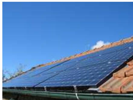
Il est possible de monter les modules photovoltaïques en portrait (dans le sens de la hauteur) ou en paysage (dans le sens de la largeur).
