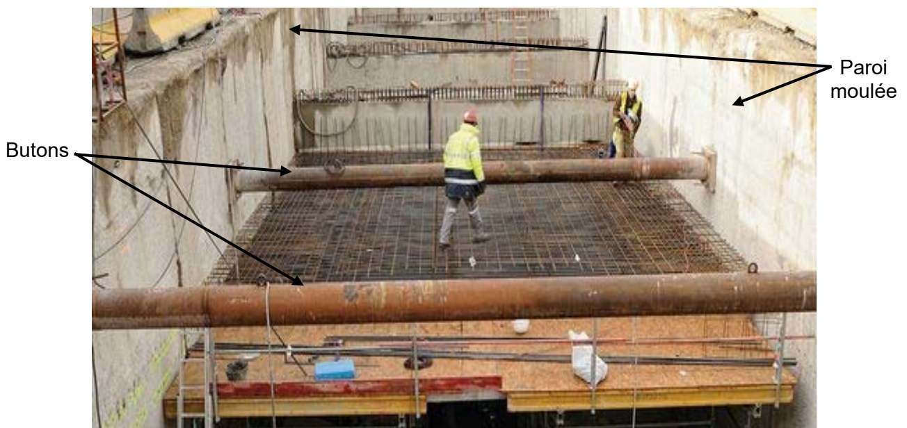
Exemple de butonnage d'une paroi (le moniteur)
