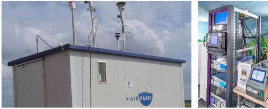
FIGURE 2 – Aspect extérieur et intérieur d’une station de mesure (source Airparif)
