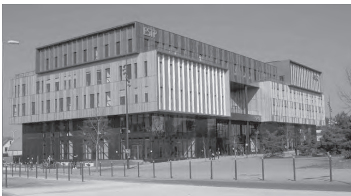
Figure 3 : Photo de l'ouvrage façades SUD – EST
