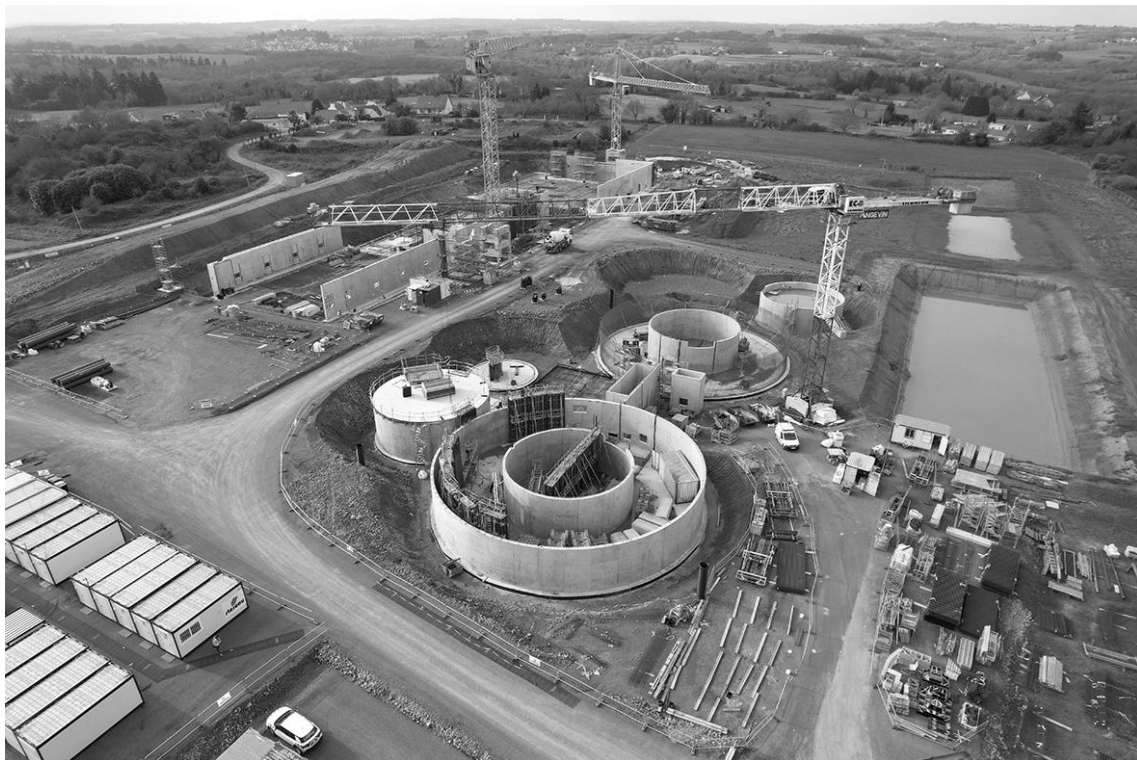
Figure 5 : vue générale de l'installation de chantier
