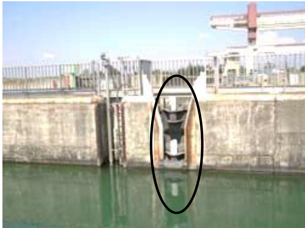
Lors du remplissage et de la vidange de l'écluse, le BOLLARD FLOTTANT s'élève ou descend par flottaison, en suivant le niveau de l'eau.
