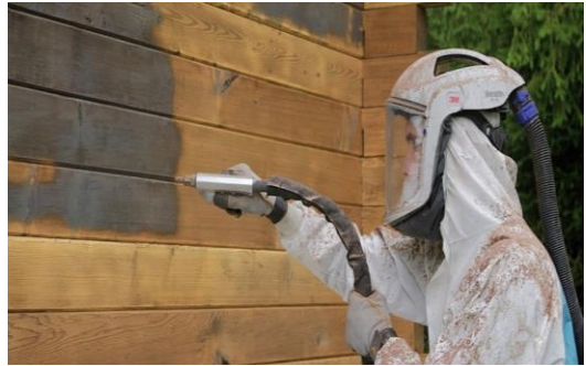
Figure 1 : Nettoyage d'une surface par aérogommage
