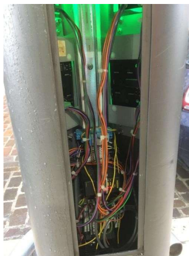
Photo de l'intérieur de la borne en cours de rénovation
