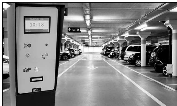
Figure 1 : système de contrôle d'accès
