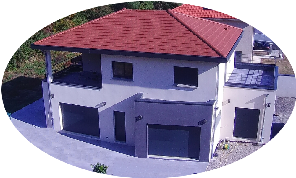
Rénovation villa Bella
