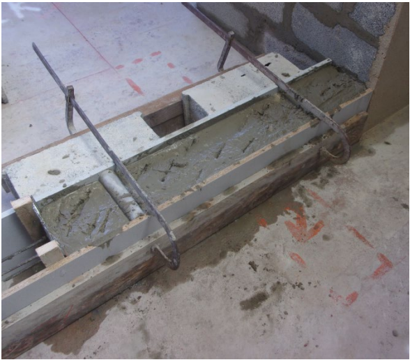
Mise en place du béton avant finition au mortier riche.
