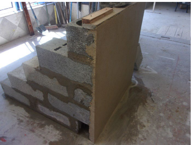
Mur BBM et enduit monocouche.
