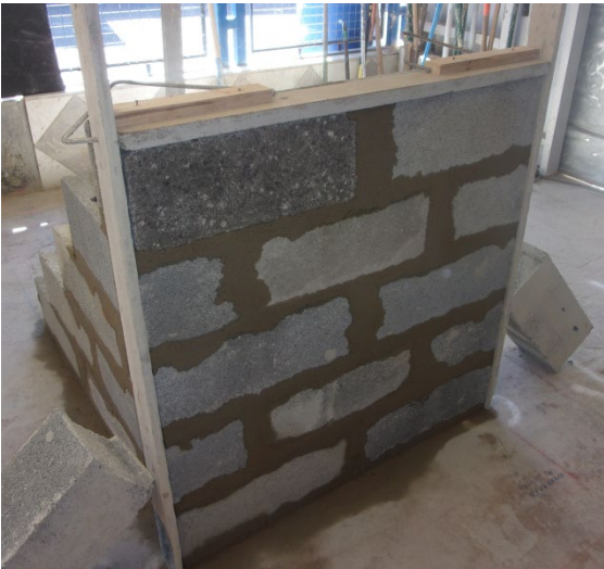
Pose des règles pour l'enduit.
