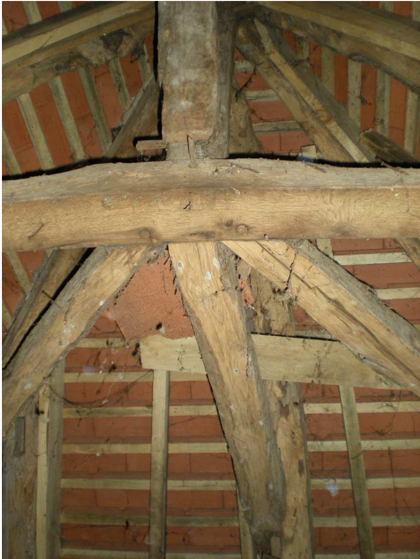
Vue intérieure de la charpente : détail de la croupe.
