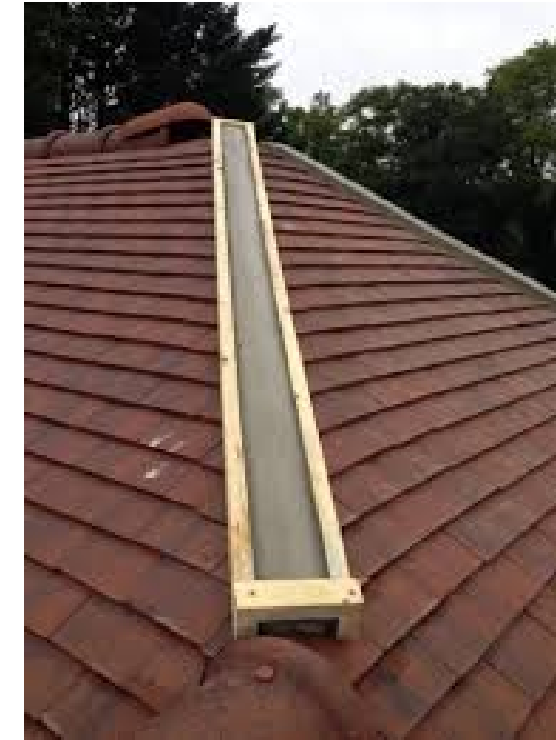
2 Coffrage de l'arêtier à l'aide de liteau
