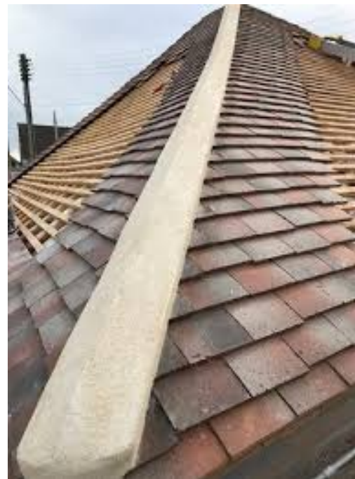
3 Finition en angle de l'arêtier
