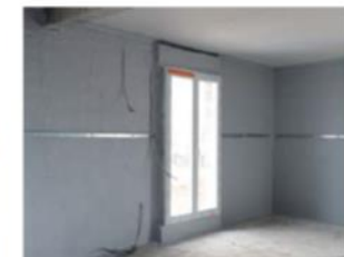
Après la projection de l'Aérobblue® et avant la pose du doublage.
