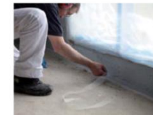
Mise en place de la bande de fibre de verre aux jonctions menuiserie/maçonnerie
