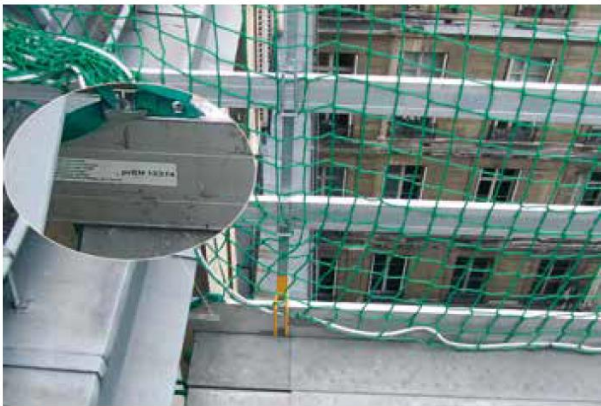
Fig. 7 – Garde-corps avec filets conforme à la norme NF EN 13374
