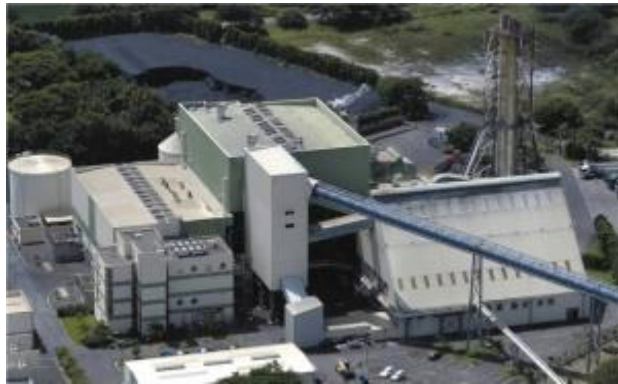
Figure 1 : centrale thermique Albioma du Moule
