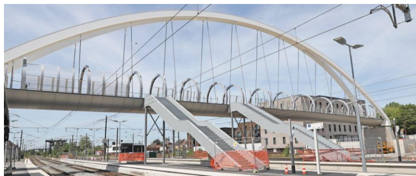
Figure 4 : photo de la passerelle piétonne
