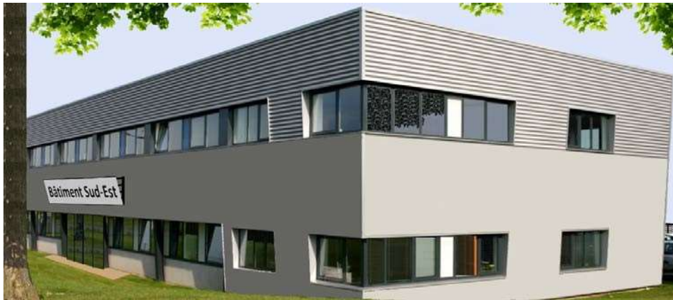
Bâtiment Sud-Est (SE) de la pépinière
