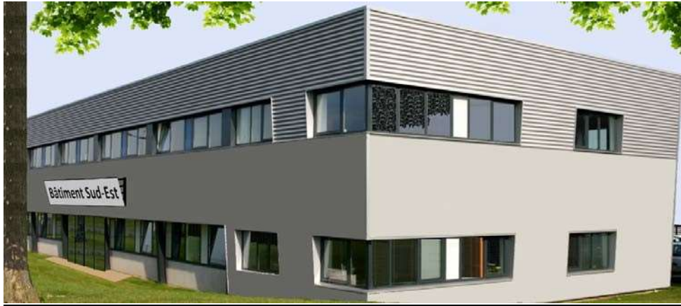
Bâtiment Sud-Est (SE) de la pépinière
