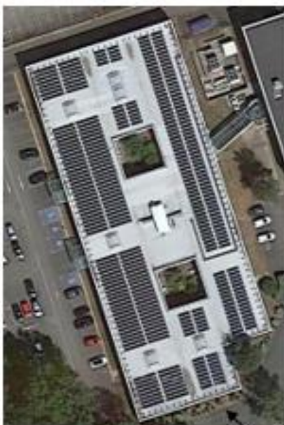
Toiture vue du ciel
