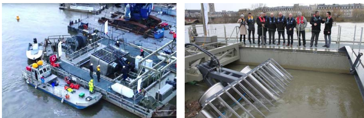
Figure 5 – Installation et inauguration de l'essai de l'hydrolienne Hydroquest River
