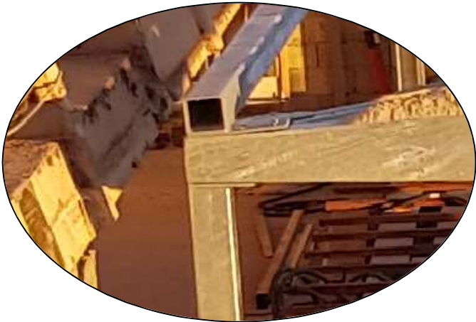
Mise en place du chéneau en bout de portique à gauche, accosté sur le trottoir du boulevard de la croisette.
