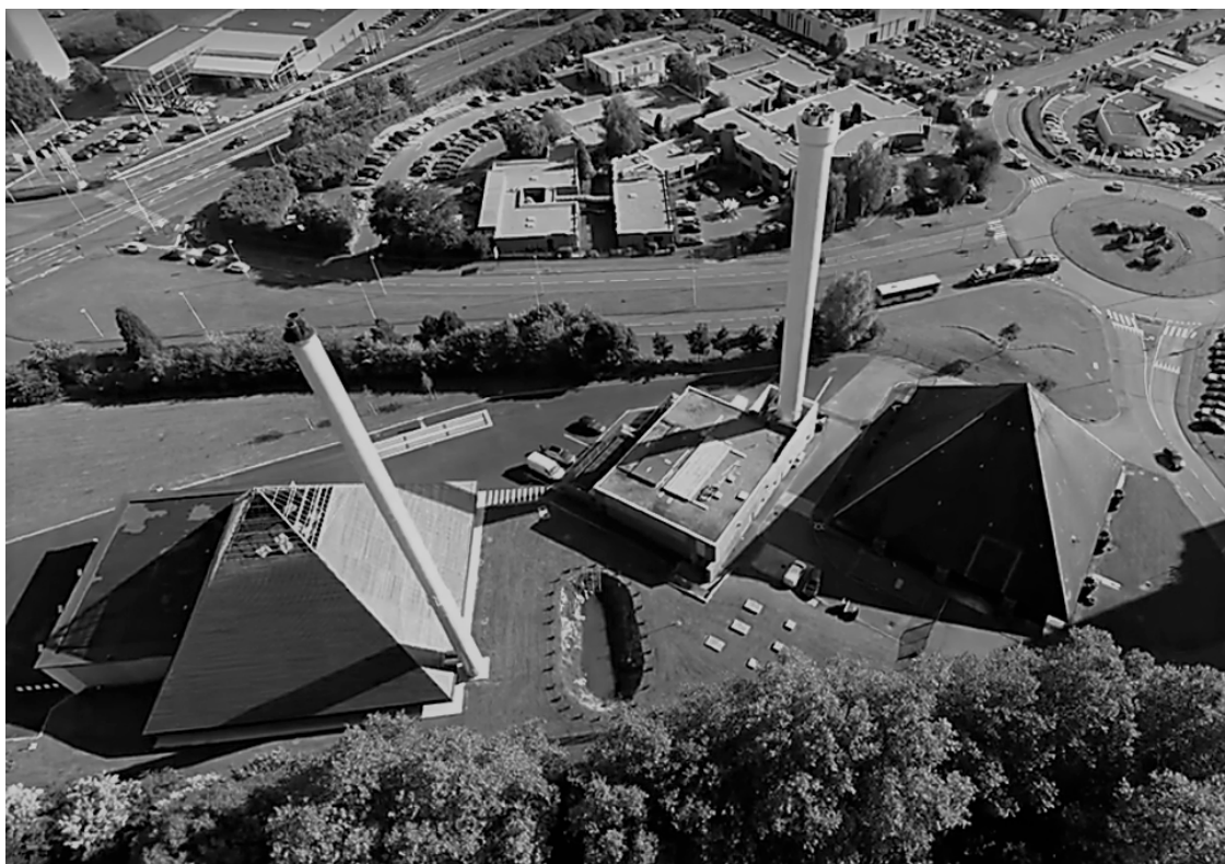
Figure 1 : chaufferie urbaine de Mons-en-Barœul
