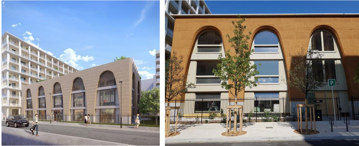
Figure 0.2. Photographie d'une des façades en pisé du bâtiment étudié.
