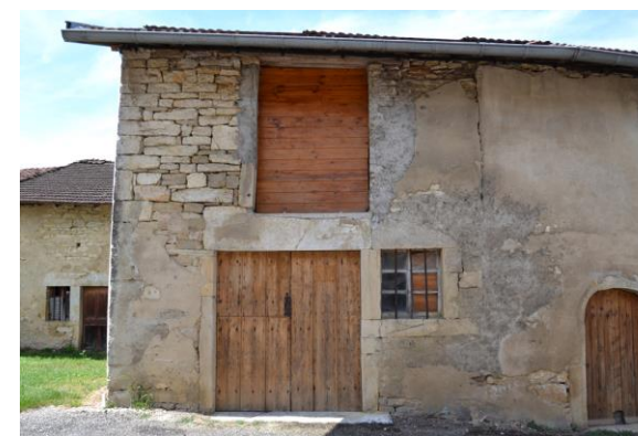
Architecture de pierre et enduit à la chaux
