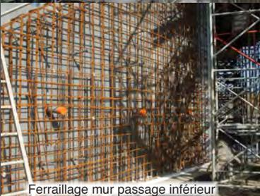
Ferrailage mur passage inférieur
