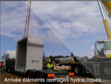
Arrivée éléments ouvrages hydrauliques
