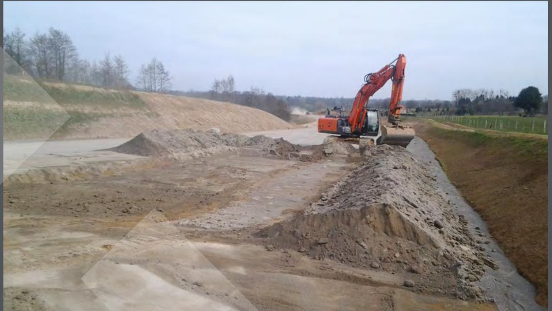
Les terrassements ont consisté en 2014 à enlever l'excédent de terre à un endroit (déblai) pour le disposer à un autre endroit (remblai), l'objectif étant que la chaussée repose alors sur des sols capables de supporter son poids en matériaux et celui des véhicules.
