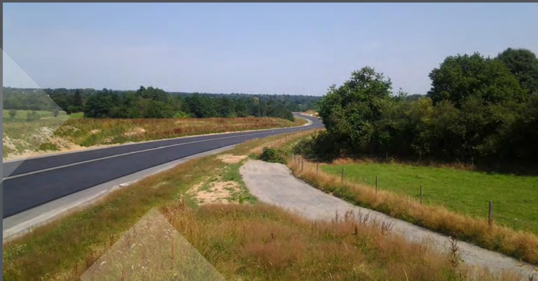
Dès le printemps 2015, une fois les terrassements achevés, une première couche de fondation en grave bitume a été posée sur une épaisseur de 7 cm. Une seconde couche de 6 cm d'épaisseur a suivi : ces deux couches assureront un rôle majeur dans la vie de la route, en répartissant le poids des véhicules sur une plus grande surface de terrain.
