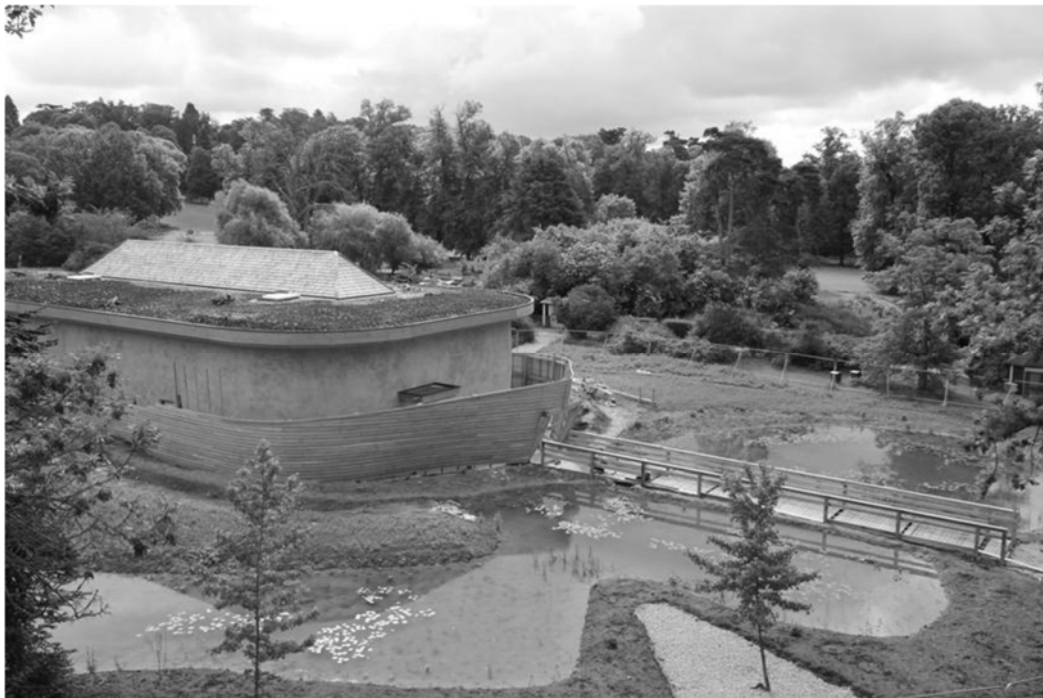
Vue aérienne de l'entrée de l'Arche des petites bêtes dans son environnement.
